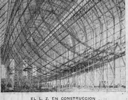
EL L. Z. EN CONSTRUCCION
